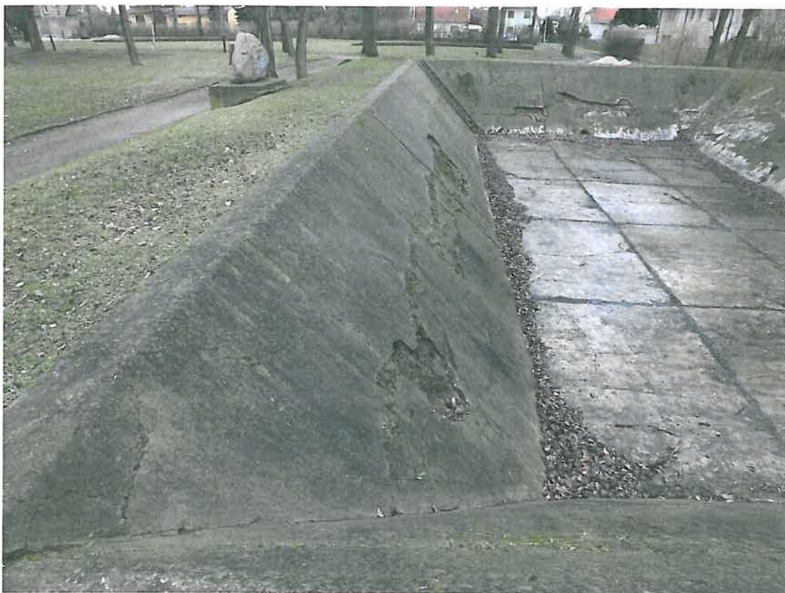
ZDJĘCIE 5- ściana basenu od strony drogi,
