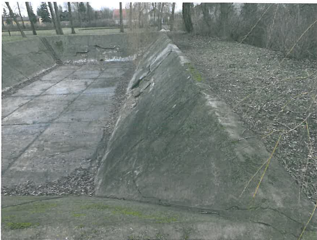
ZDJĘCIE 2- widok ściany bocznej, dłuższej, basenu p-poż,
