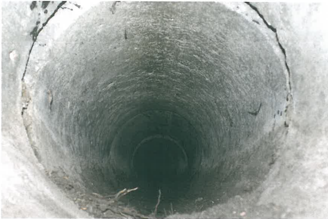
ZDJĘCIE 17- kanalizacja deszczowa,
