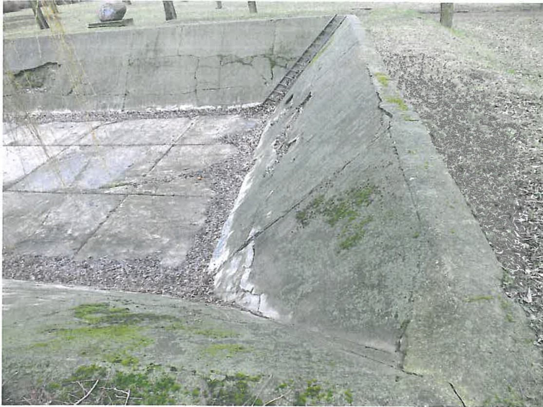
ZDJĘCIE 1- widok ściany bocznej, krótszej, basenu p-poż,
